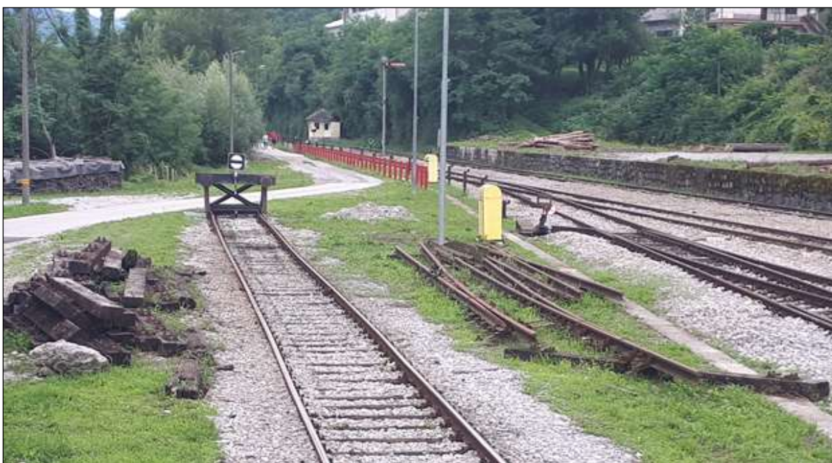
Slika 2: Tir 1 s tirnim zaključkom, kretnici 2 in 3, v ozadju zaključek nakladalne klančine za les
